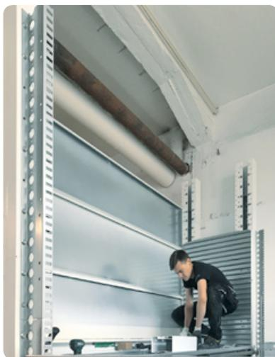
Alle LTL Lagertürme sind in 500 mm Schritten von 2,5 bis zu 15 Meter Höhe lieferbar und für eine Gesamttragkraft von 66 Tonnen ausgelegt. Aufgrund der modularen Bauweise kann der Lagerturm jederzeit aufgestockt werden. Bei einem Umzug kann er problemlos zurückgebaut und den neuen Gegebenheiten angepasst werden.
